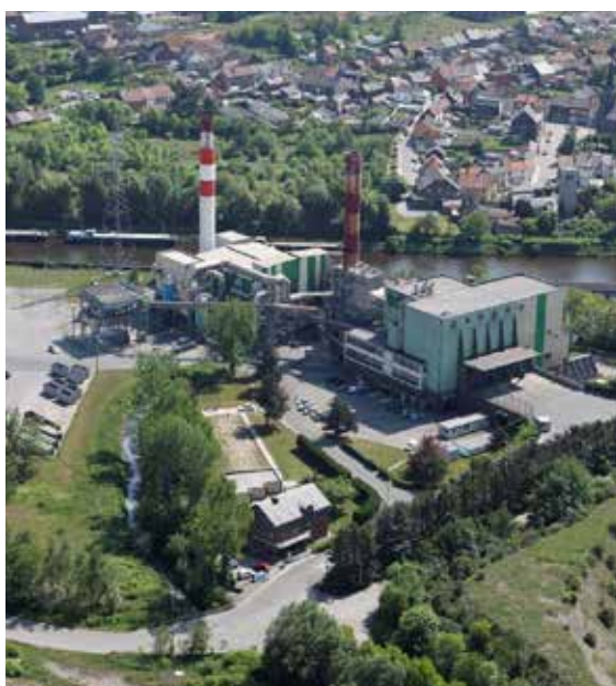
VUE AÉRIENNE DE L'UNITÉ DE VALORISATION ÉNERGÉTIQUE.
